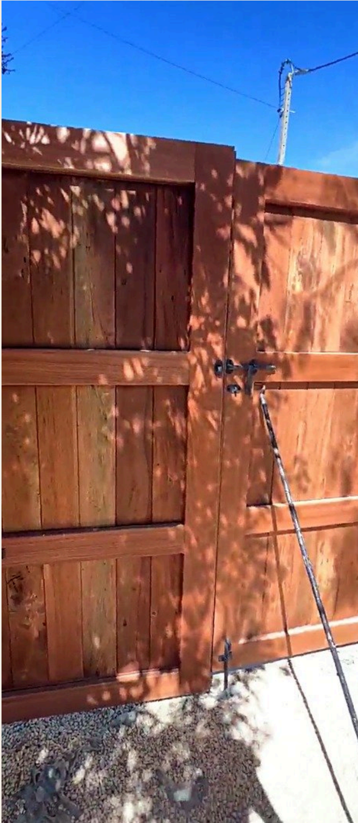
Portão de duas folhas em madeira, com ferragens em ferro
