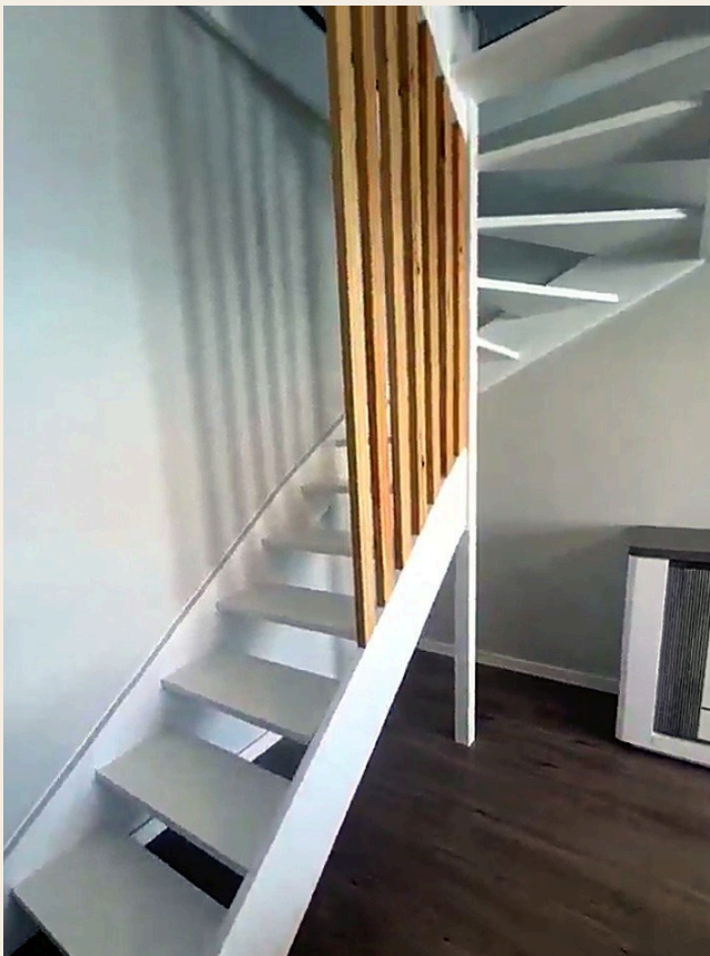
Ripado vertical em madeira junto a escada
