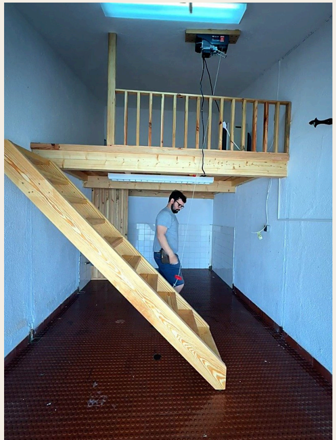
Mezanino com escada e guarda em madeira
